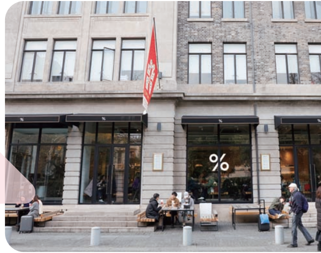
上海洛克外灘源協進大樓
